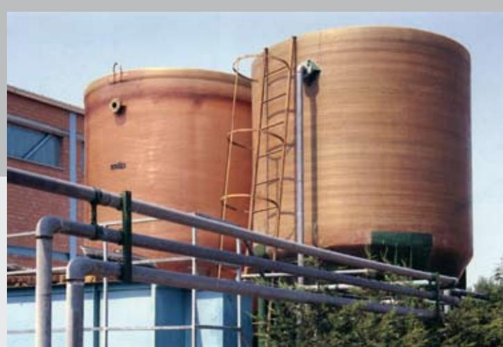
Sedimentatore-Decantatore per liquami, capacità 25 m<sup>3</sup>.
